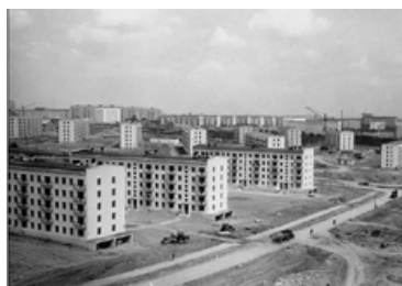
Район панельных «хрущевок». 1960-е гг
